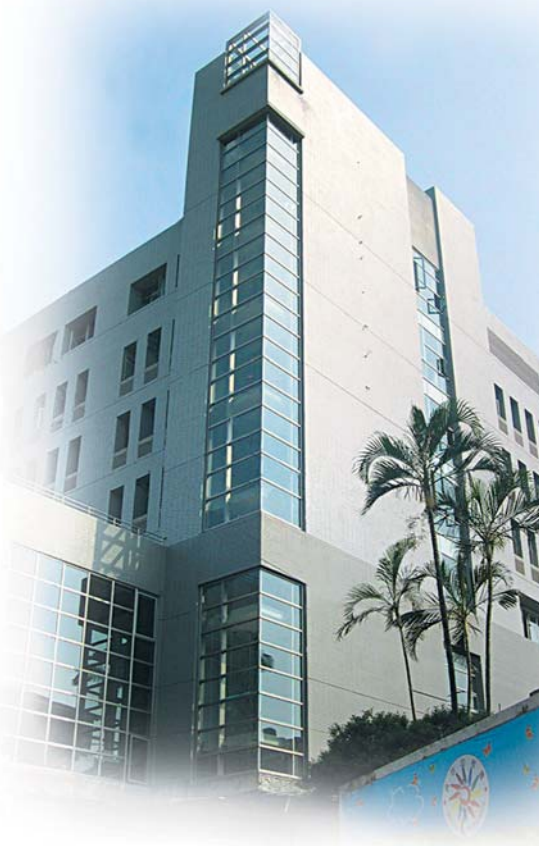
↑ 新大樓（大學路81巷實景）九層結構體已全部完工，現正進行內部裝潢中
